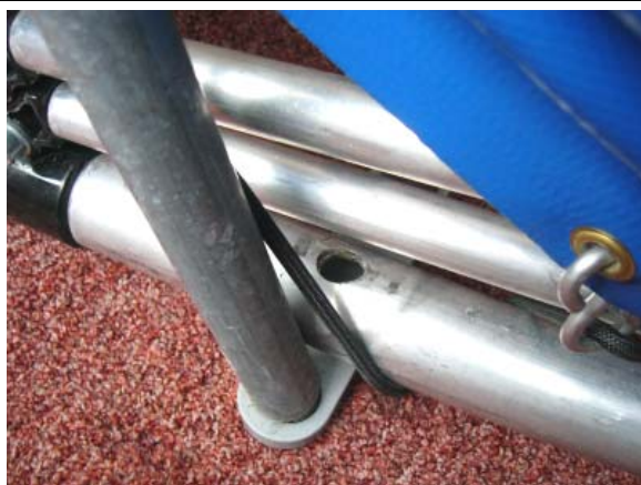
Obrázek H Upevnění plachty suchými zipy k obloukům.
