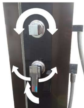
Detail ovládací páky a přepínacího ventilu
