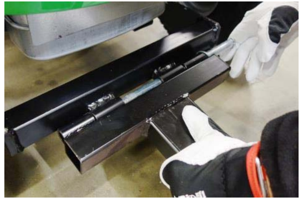
6. Nasadte radlicu, zasuňte čap a zaistite podložkou a závačkou.
